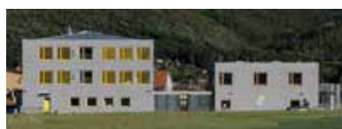
Stávající budova ZŠ Lety
